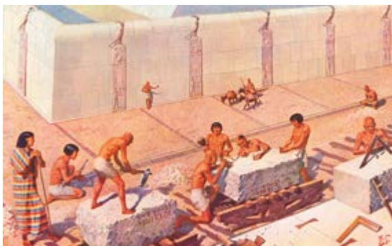
Figura 5 - Preparação dos blocos de pedra talhada (Herget)
